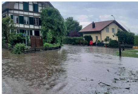
Brügglen: Überflutete Hauptstrasse
