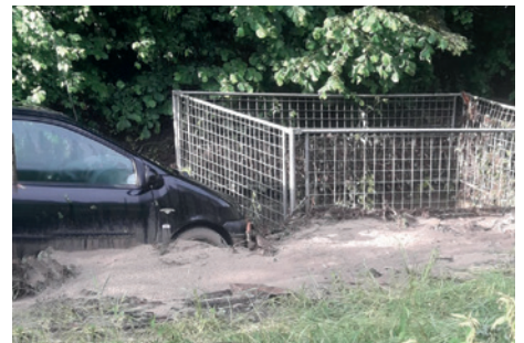
Aetingen: Überfluteter Einlauf oberhalb der Kirche
