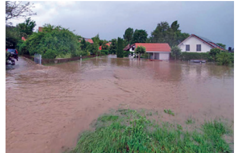
Küttigkofen: Gebäude an Dorfstrasse überflutet
