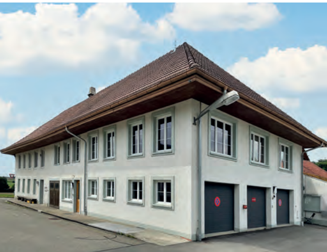
Altes Schulhaus Lütterswil
